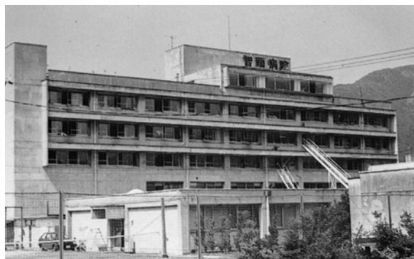
図2 昭和46年に建て替えられた時の病院 鉄筋コンクリートで地下1階、地上6階であった。
