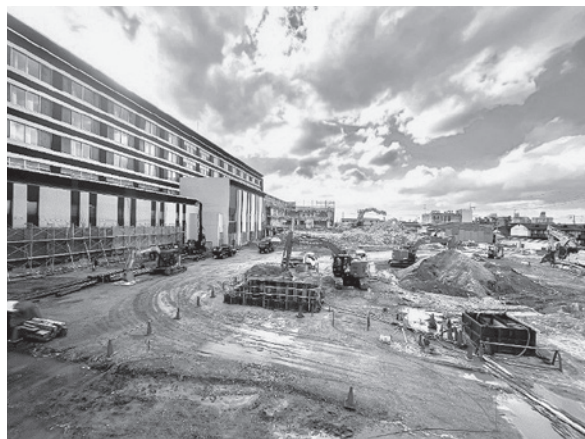
図3 旧病棟が撤去され、駐車場整備が進められた (2025年2月)
