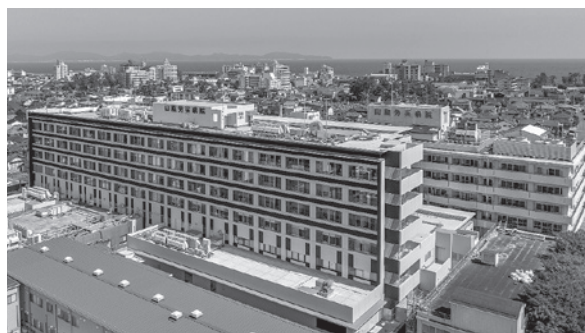
図2 新病棟完成(北側に残る旧病棟)(2023年7月)
