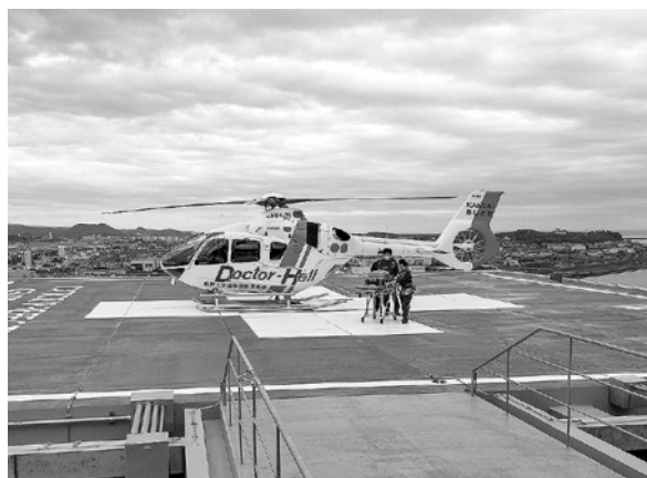
図4 屋上ヘリポート
