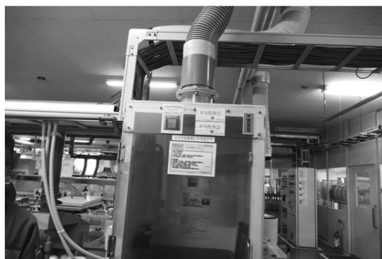
シアン化物/有機溶剤用の局所排気装置
