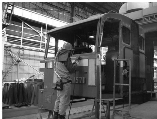
外板塗料の研磨作業
