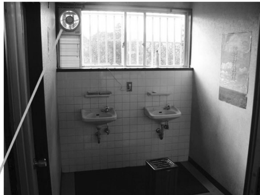
喫煙室としての間仕切り（出入口）がないので暖簾を設置し、かつ窓は閉めるべき！
