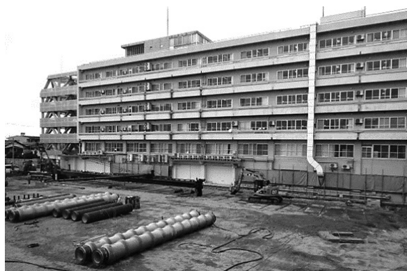
写真2 南東方向から見た昭和38年設立の旧棟とその手前、南側の新棟西側部分の建設用地(令和元年8月)
