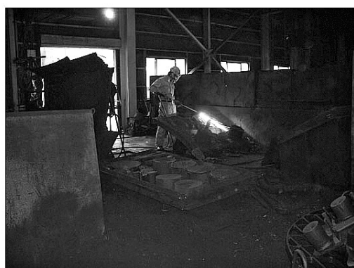
ガウジング作業 （アーク溶接による溶断）
