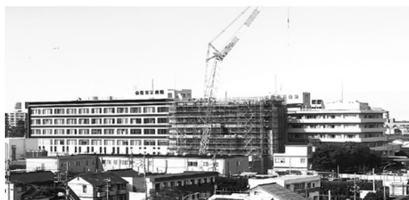
写真4 南から見た工事中の新棟東側部分 (令和4年11月)
