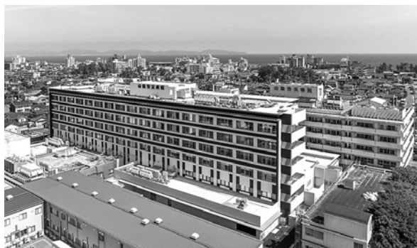
写真1 南東方向から見た、東西部分ともに完成した新棟(手前)と北側の旧棟(令和5年7月)
