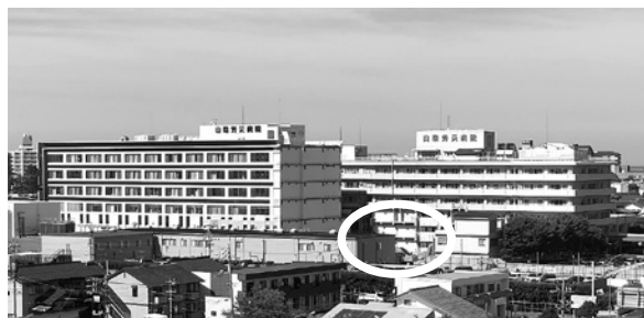
写真3 南から見た新棟西側部分と北側の旧棟(令和3年12月)
