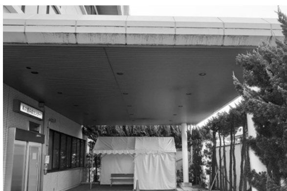
図2 旧ドライブスルー施設
