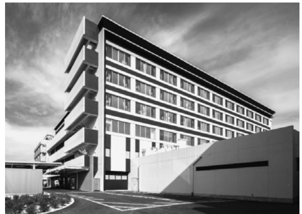
写真4 南西から見上げた新棟
