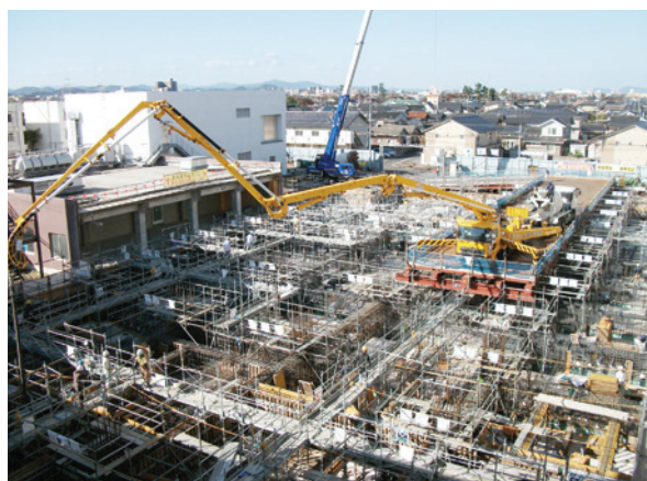
写真5 工事現場風景
