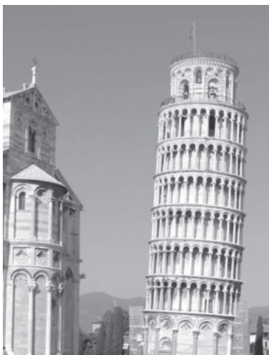
図1 ピサの斜塔 南へ3.99度傾斜
