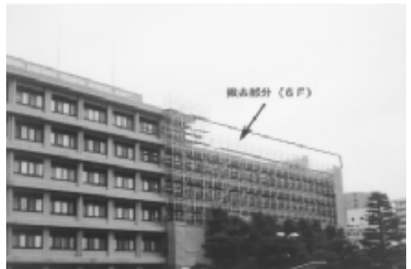
改修後（現在の工事状況）
