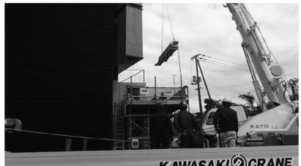
写真2 免振ダンパーの取り出し
