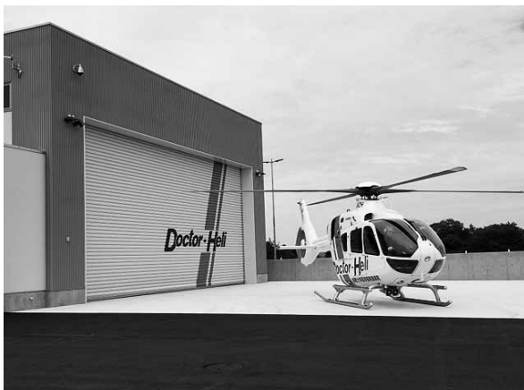
写真1 米子空港に整備された格納庫外観
